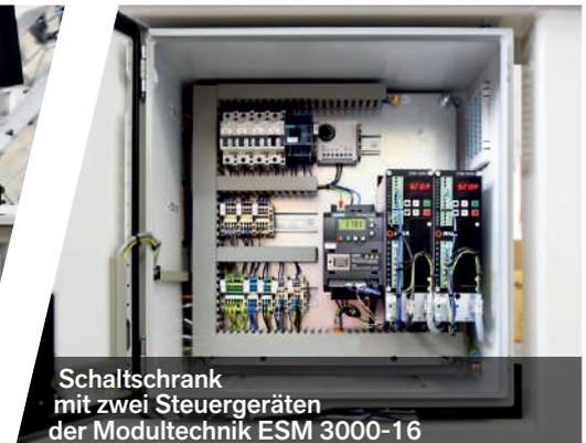
Schaltschrank mit zwei Steuergeräten der Modultechnik ESM 3000-16
